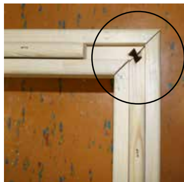
Fig. 2: Unir os elementos do chão
