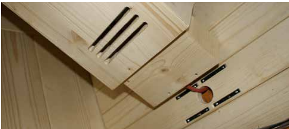
Fig. 29 : Fixer le radiateur avant
