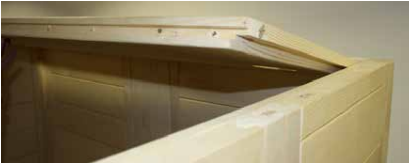
Fig. 18 : Insertion de l'élément de toit avant
