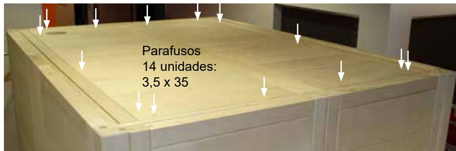
Fig. 19: Fixação dos elementos de teto
