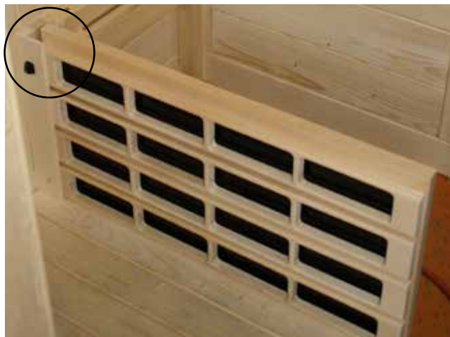
Fig. 34 : Insertion de la plaque chauffante IR VitaMy 164
