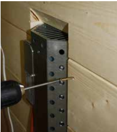
Abb. 42: Blende der Rückenstrahler montieren
