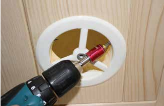
Fig. 36 : Montage de la ventilation
