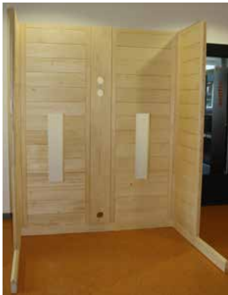
Fig. 7 : Paroi arrière montée
