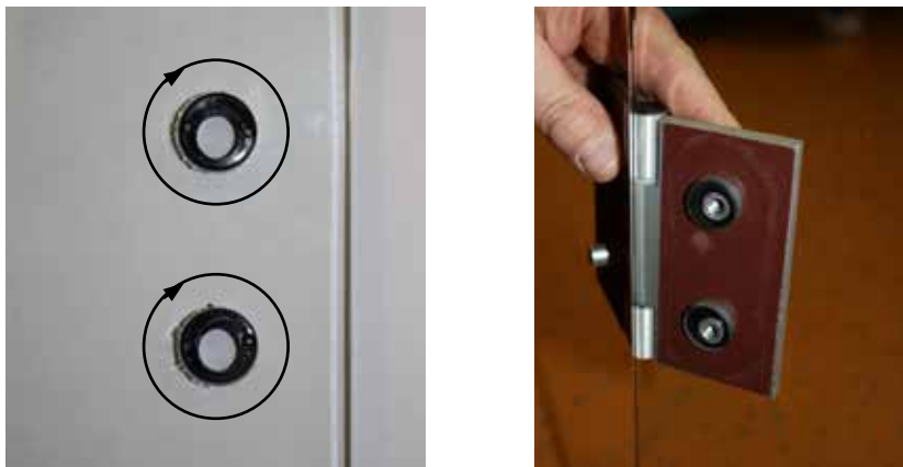
Fig. 22: Montagem das ferragens da porta 1
