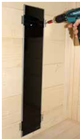
Fig. 41 : Monter le radiateur arrière (radiateur infrarouge ECO 350)
