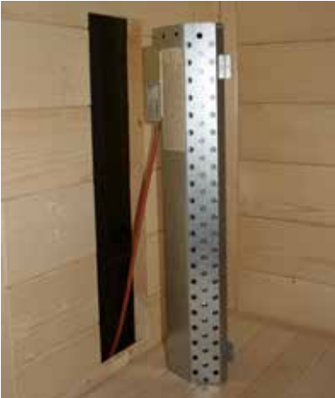
Abb. 41: Rückenstrahler (Infrarot-Strahler ECO 350) montieren
