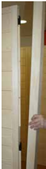
Afb. 9: Montage van de twee voorste hoekstanders met groef voor glas
