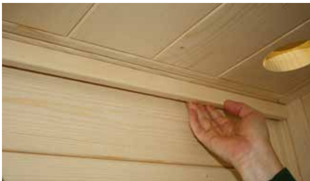
Fig. 38 : Collage de la bande LED
