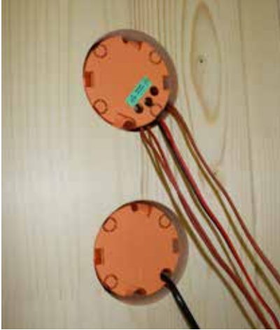
Fig. 48: Ligação da unidade de comando
