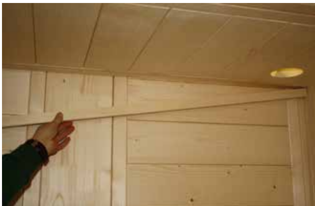
Abb. 37: Montage der LED-Abdeckleiste
