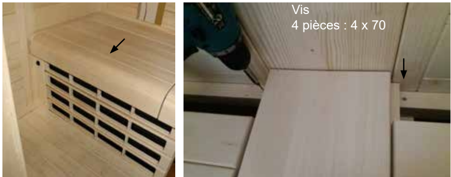
Fig. 51 : Fixation du banc
