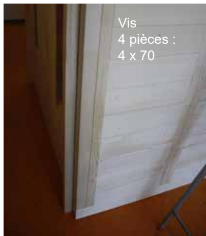
Fig. 52 : Montage des barres d'écartement paroi arrière
