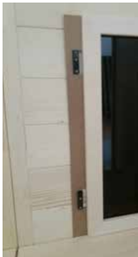
Fig. 53: Montagem dos encostos
