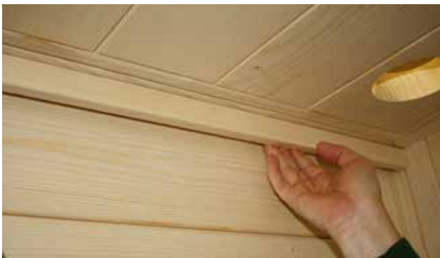
Fig. 38: Colagem da tira LED
