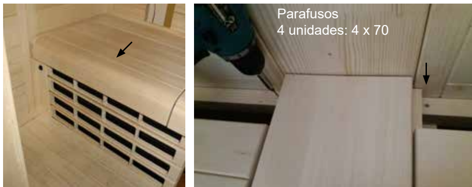
Fig. 51: Fixação do banco
