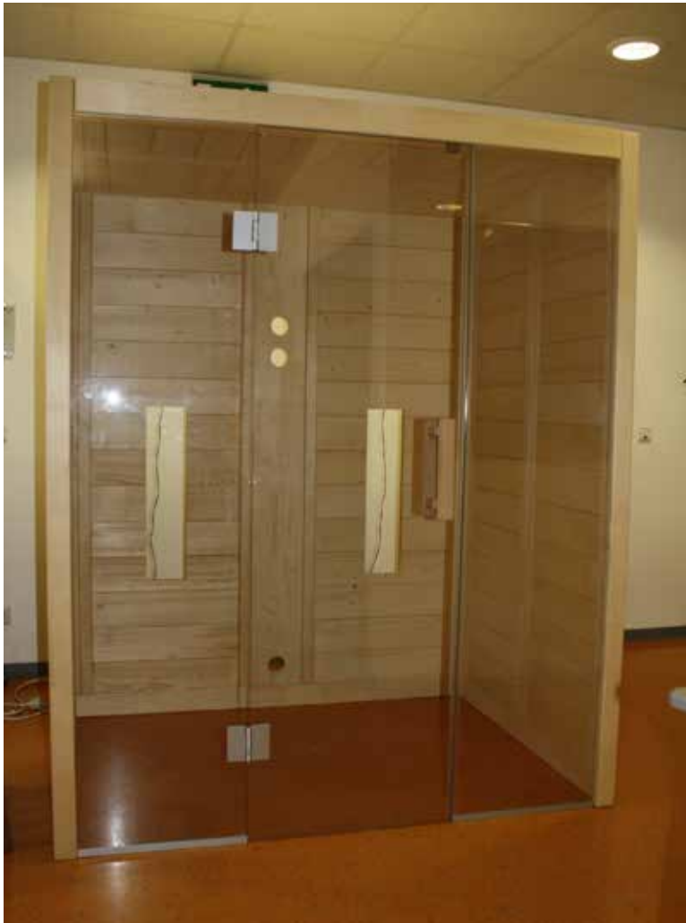
Fig. 26 : Murs de cabine et éléments de toit finis
