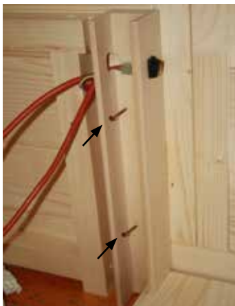
Fig. 33 : Montage des barres en U pour les plaques chauffantes
