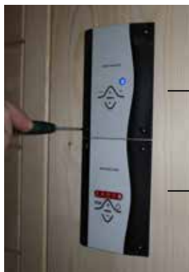
Fig. 46 : Montage de l'élément de commande
