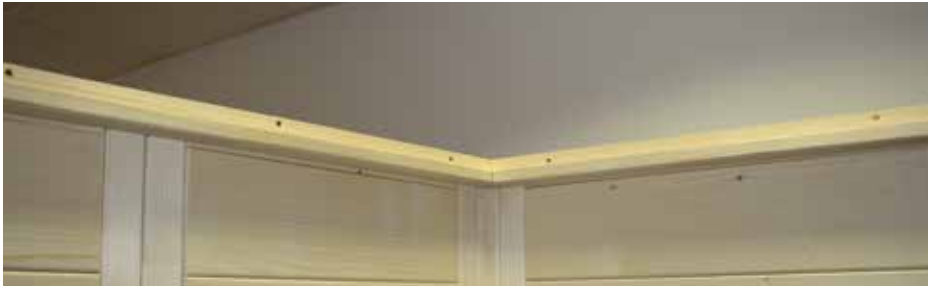
Abb. 17: Einlegen Dachelement hinten mit Lüfterausschnitt
