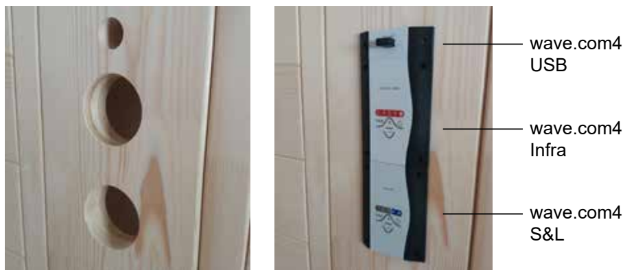
Fig. 49: Montagem da unidade de comando
