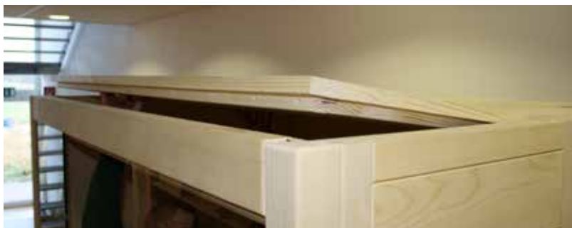
Fig. 18: Inserção dos elementos de teto da frente
