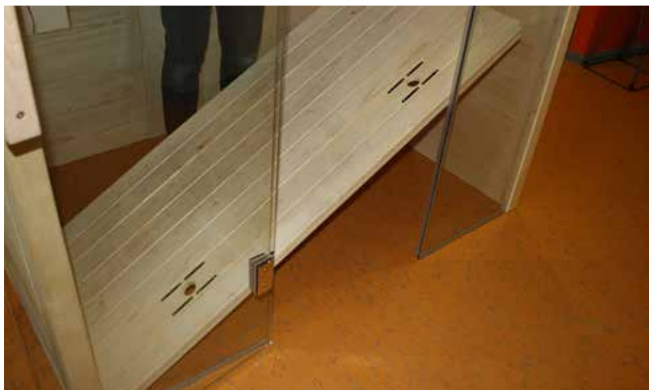
Fig. 28 : Poser le plancher de la cabine
