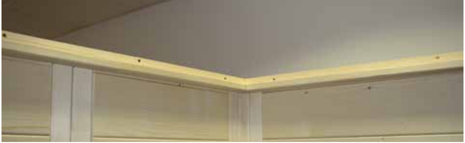
Fig. 17 : Insertion de l'élément de toit arrière avec la découpe du ventilateur
