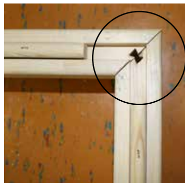
Fig. 2 : Raccorder les éléments du plancher
