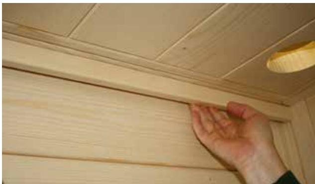
Abb. 38: Einkleben des LED Stripes
