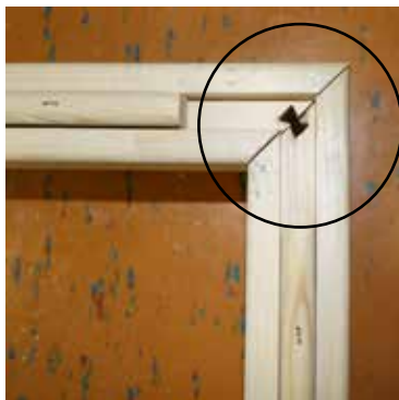
Abb. 2: Bodenelemente verbinden
