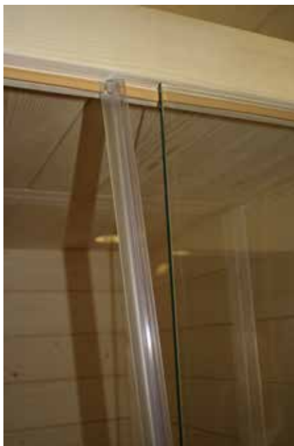
Fig. 20: Colocação da vedação da porta
