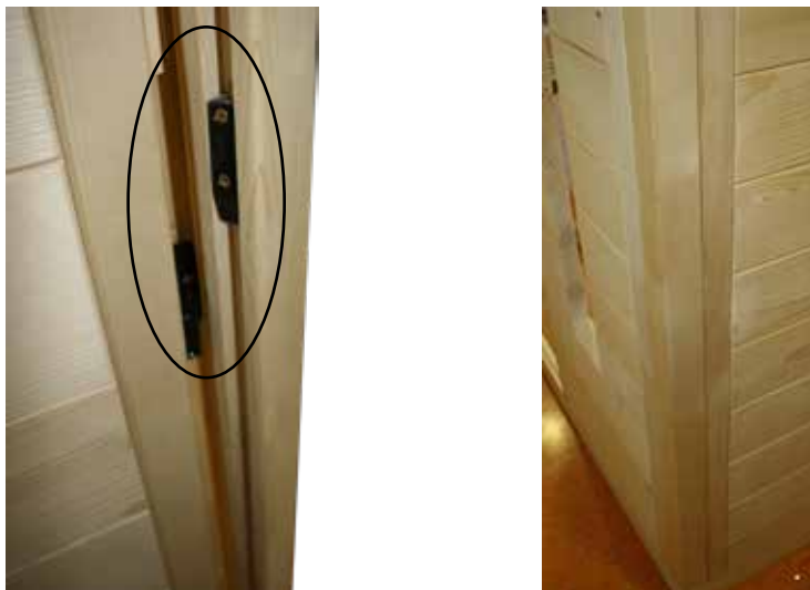
Fig. 4 : Raccorder les éléments muraux avec les montants d'angle
