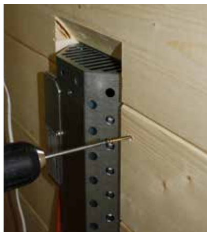
Fig. 42: Montar o painel dos radiadores traseiros
