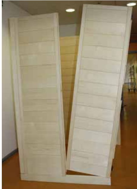
Afb. 9: Montage van de twee voorste hoekstanders met groef voor glas
