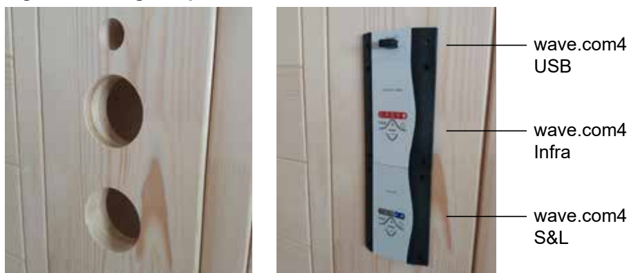
Fig. 49 : Montage du panneau de commande
