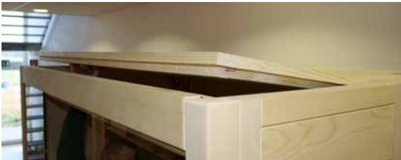
Abb. 18: Einlegen Dachelemente vorne
