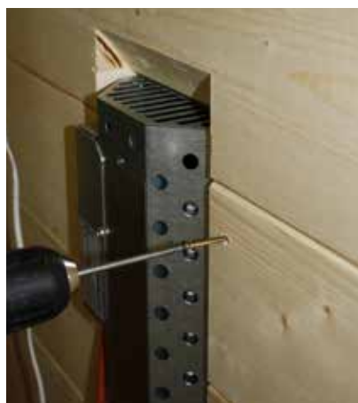
Fig. 42 : Monter le cache du radiateur arrière
