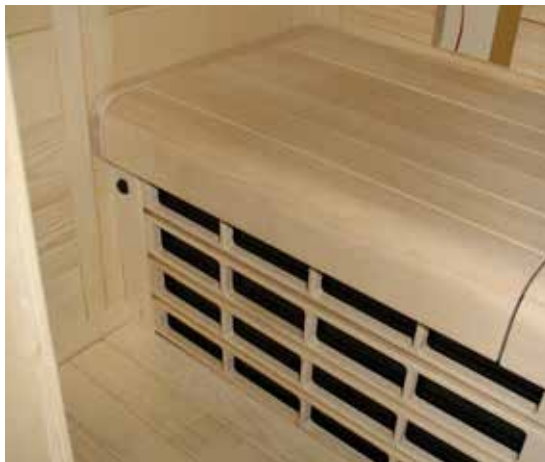
Fig. 40 : Pose du banc
