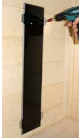
Abb. 41: Rückenstrahler (Infrarot-Strahler ECO 350) montieren
