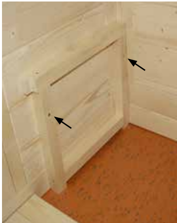
Fig. 32: Montagem do apoio do banco
