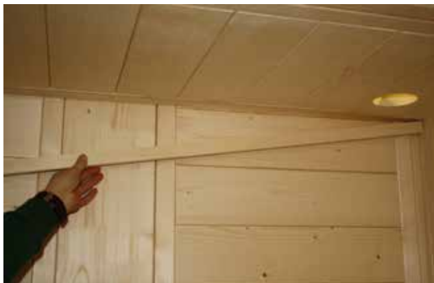
Fig. 37: Montagem da barra de cobertura LED
