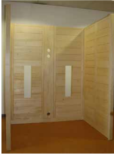
Fig. 10: Elementos de parede montados
