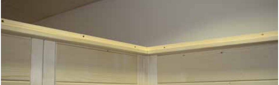
Afb. 17: Plaatsen van dakelement achter met ventilatoruitsparing
