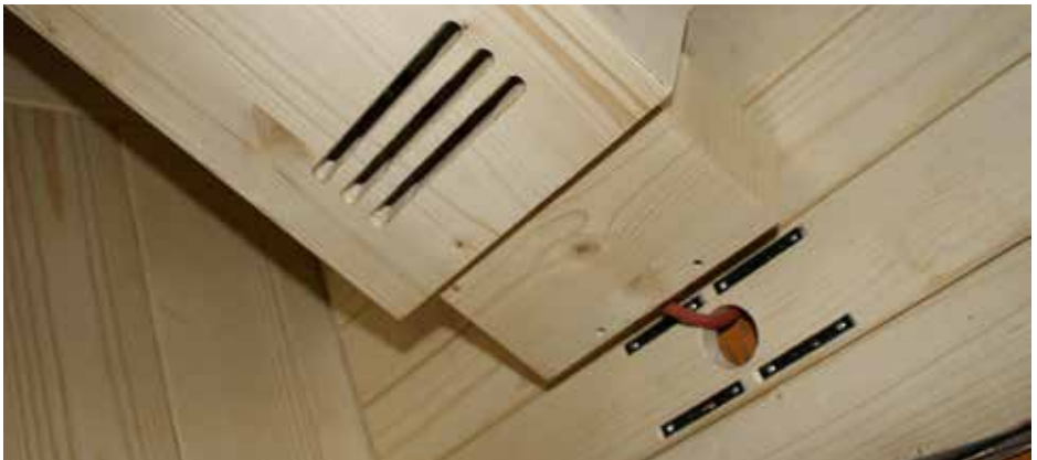
Fig. 29: Fixar o radiador frontal
