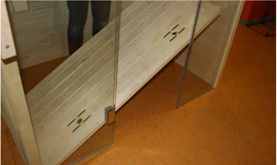
Fig. 28: Inserir o chão da cabina
