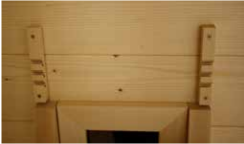
Fig. 54: Montagem dos apoios de cabeça
