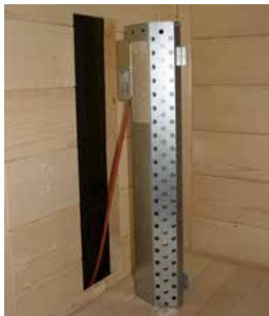
Fig. 41: Montar o radiador traseiro (radiador de infravermelhos ECO 350)
